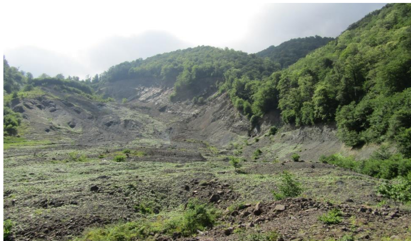
Рис. 16. Сочинский полигон. Кепшинский участок. Вид на головную часть Кепшинского оползня
