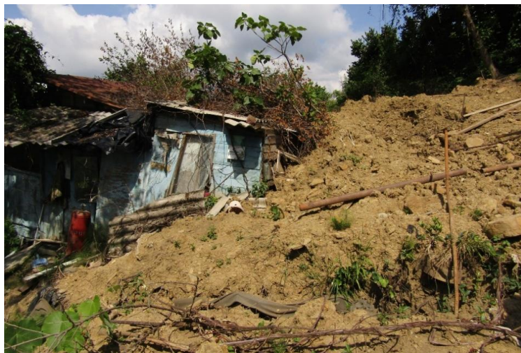
Рис. 23. Разрушенный дачный дом на участке № 21, в языковой части оползня
