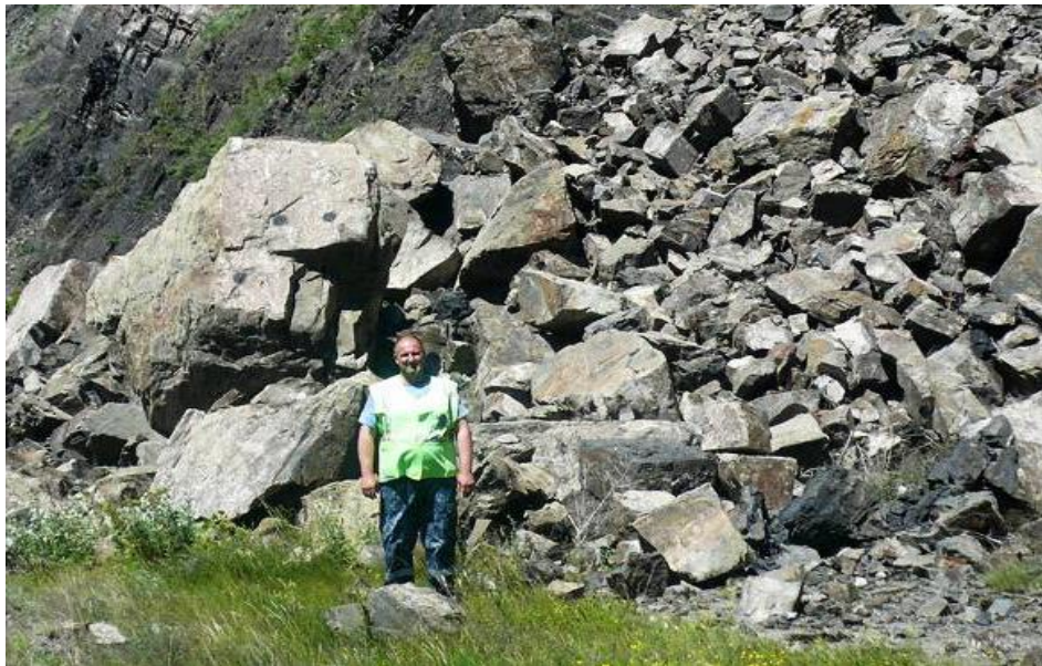
Рис. 13. Обвал на внешней стенке Луарского тоннеля
