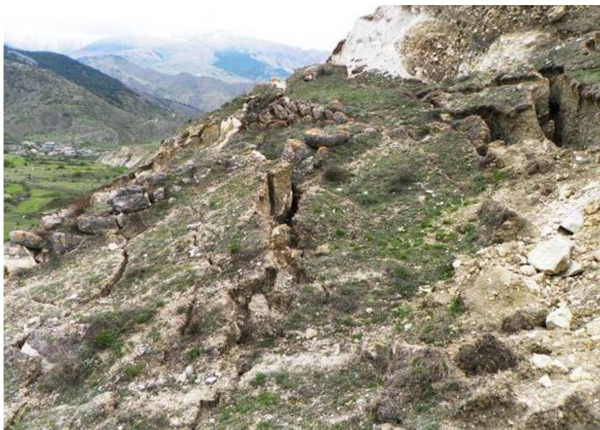
Рис. 11. Деформации на теле Калнахтинского оползня
