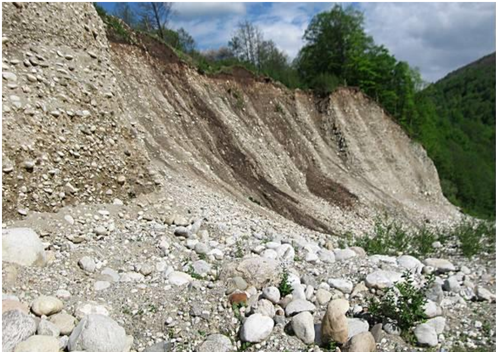
Рис. 8. Осыпь в верховом откосе автодороги Чикола-Мацута, км 21
