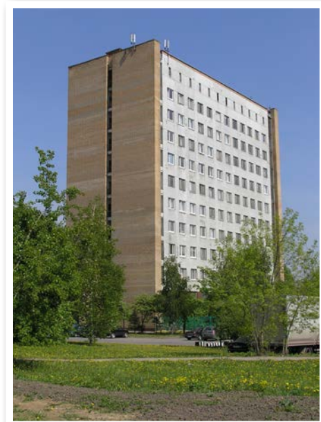
Здание ЦНИГРИ, 2020 г.
