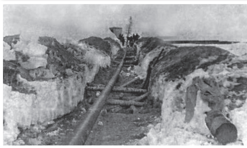
Строительство нефтепровода шло и зимой, в суровые морозы
