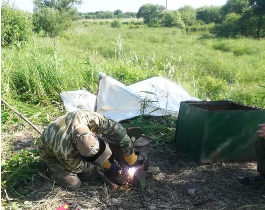
Рис. 1. Установка внутреннего лючка под прибор
