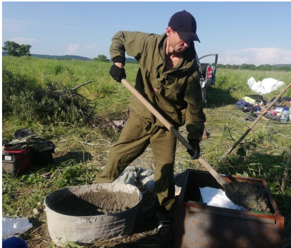
Рис. 2. Бетонирование железного короба
