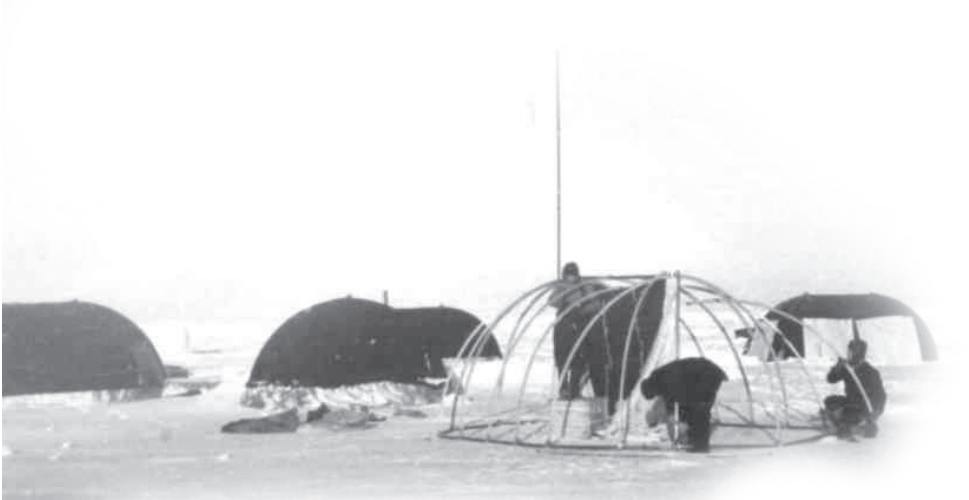
Строительство лагеря – установка каркаса палатки КАПШ-2.
