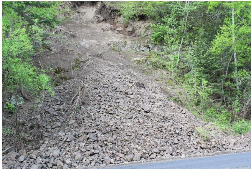
Павловская. Активизация процесса осыпания на участке 223,6 км автодороги Осиновка-Р. Пристань по состоянию на 27.05.2020 г.
