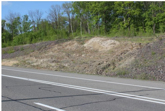
Боёвка 2. Активизация процесса оползания на участке 677,7 км автодороги А-370 «Уссури» по состоянию на 26.05.2020 г.
