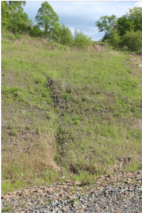
«Раздольненский 2». Трещина отрыва тела оползня по состоянию на 26.05.2020 г.
