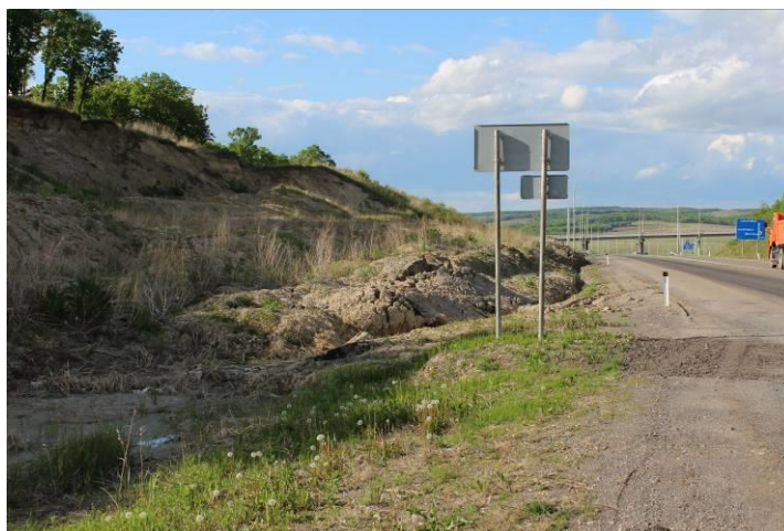
«Уссурийский». Влотекущая активизация оползневого процесса по состоянию на 26.05.2020 г.
