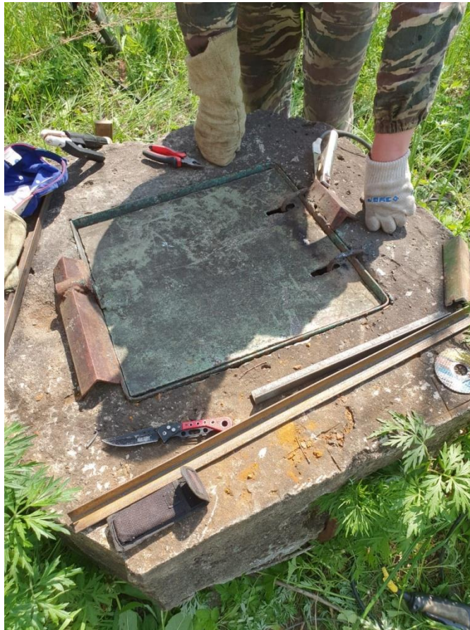
Рис. 3. Ремонт антивандального сооружения
