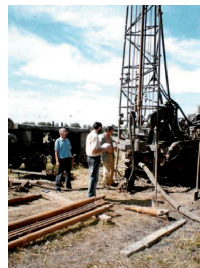
Заложение разведочных скважин на Ардатовском месторождении подземных вод
