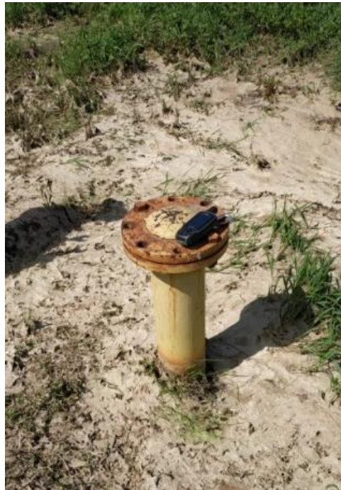
Рис. 12. Обследование колодцев и наблюдательных скважин в п. Буланаш
