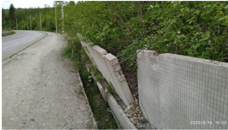
Рис. 15. Укрепление оползневого склона в п. Максимовка (Участок Миньярский)
